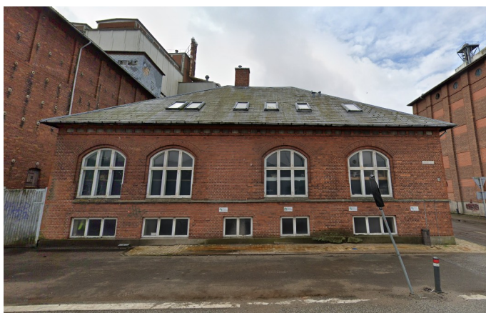
Den tidligere kontor- og kantinebygning, som den ser ud i dag.
