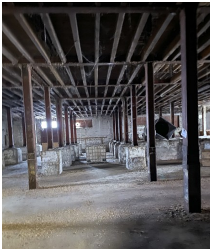
Stueetagen i dag. Kraftige, bærende søjler i stål og tætliggende bjælker i træ.
