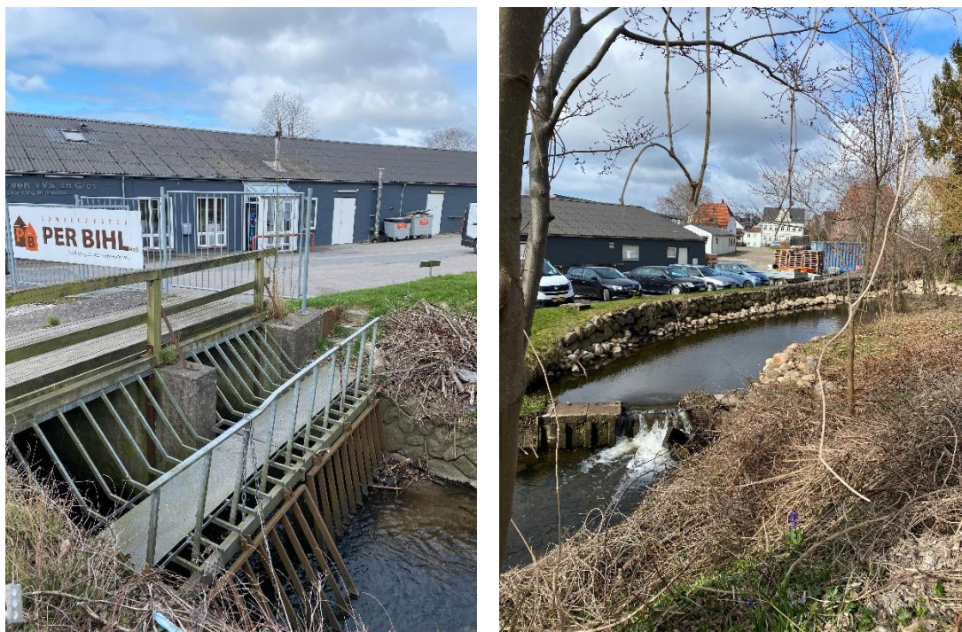
Figur 12 Tv. Kobberbækkens indløb til den rørlagte strækning. Som en del af rørlægning er der et større styrt, der sandsynligvis er en bevarelse af den gamle frisluse for nederste Ørkilds Mølle. Th. Tidligere mindre opstemning nederste Ørkilds Mølle
