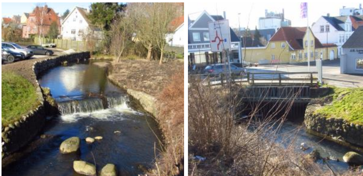
Figur 3 T.v. Mindre opstemning nederste Ørkilds Mølle denne er dog fjernet forår 2023T.h. Kobberbækkens indløb til den rørlagte strækning. Som en del af rørlægning er der et større styrt, der sandsynligvis er en bevarelse af den gamle frisluse for nederste Ørkilds Mølledam.
