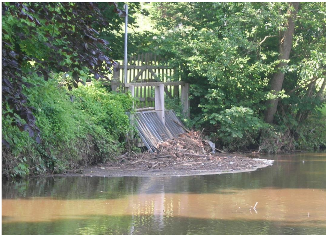
Figur 5 Ophobet materiale på frislusens risteværk den 30. juni 2012 (billede: Daværende ejer af Nyborgvej 25, via Vand & Affald)
