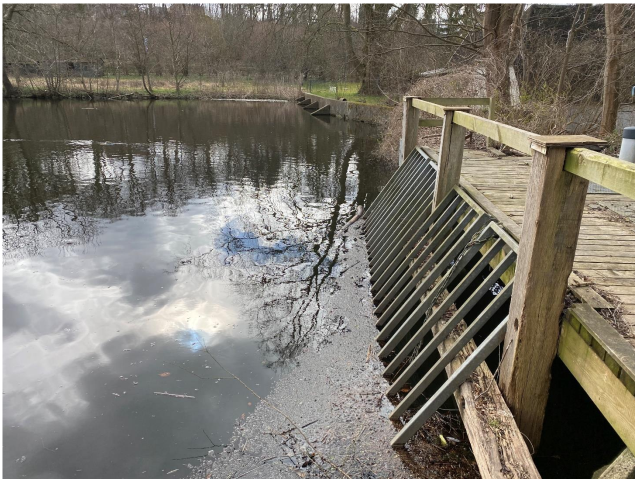
Figur 11 Dæmning med støttemur og risteværk foran frislusen
