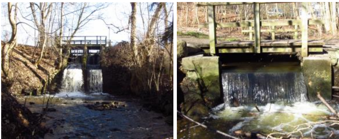
Figur 2 T.v. Opstemning (frislusen) for øverste Ørkilds Mølle. T.h. Opstemning i Trappebækken til indtag af vand til dam ved Caroline Amalie Vej (beliggende nordvest for Ørkilds Mølledam)
