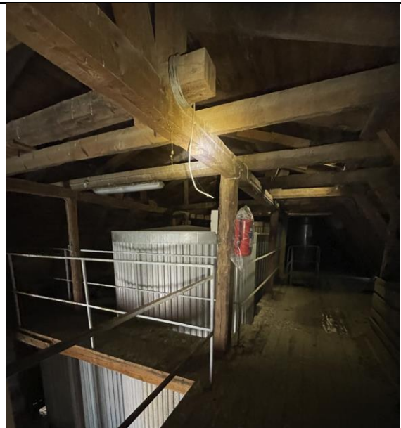
Bygning B – oprindeligt gammelt pakhus. Trækonstruktioner og indbyggede stålsiloer.
